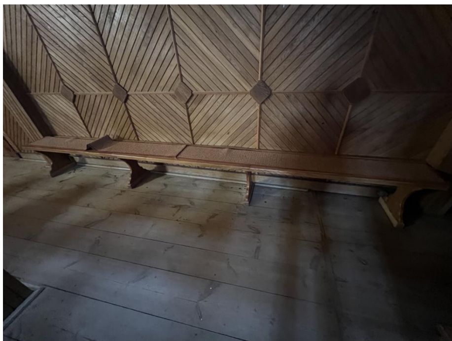
Rys.: Istniejący stan desek podłogowych w Kościele pw. św. Małgorzaty w Olchowcu.
