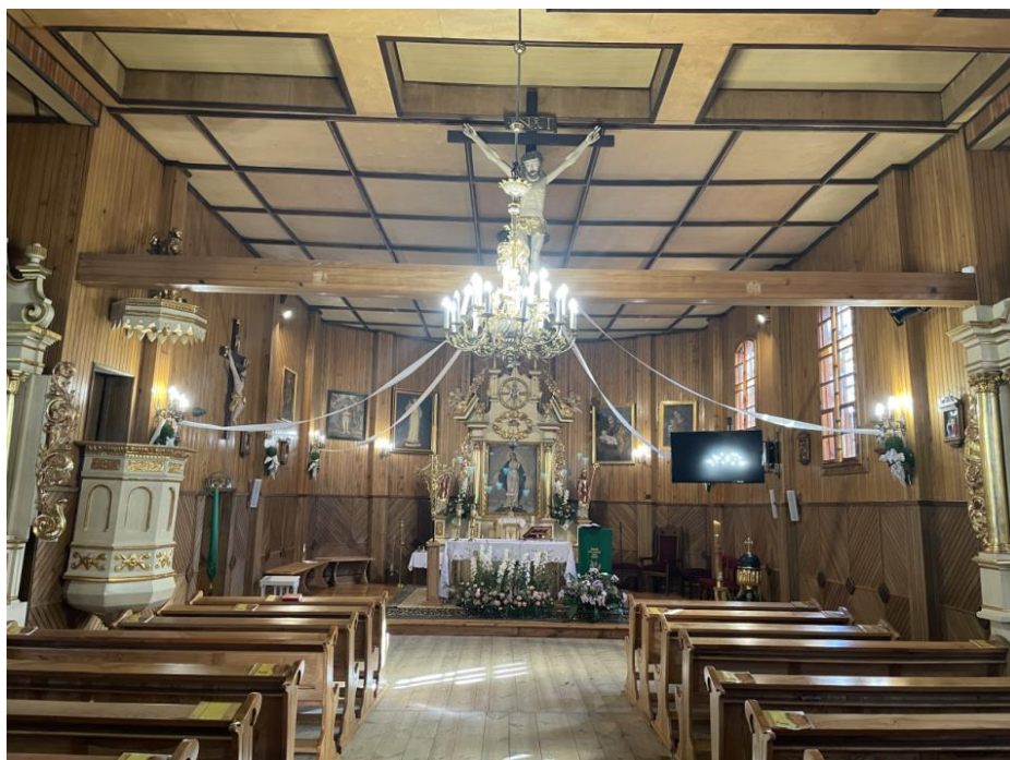
Rys.: Istniejący stan deskowania sufitu w Kościele pw. św. Małgorzaty w Olchowcu.
